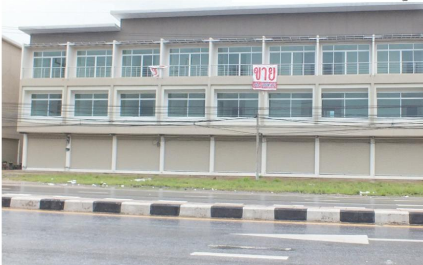
ยอดขายฝืด - อาคารพาณิชย์ที่ก่อสร้างเสร็จใหม่ในเขตเมืองมหาสารคามติดป้ายประกาศขายจำนวนมากในโซนถนนเศรษฐกิจใหม่ เนื่องจากยอดขายซบเซาหนัก ขณะที่โครงการบ้านจัดสรรก็ออกโปรโมชั่นลดแลกแจกแถมแย่งลูกค้ากันสนั่นเมือง
